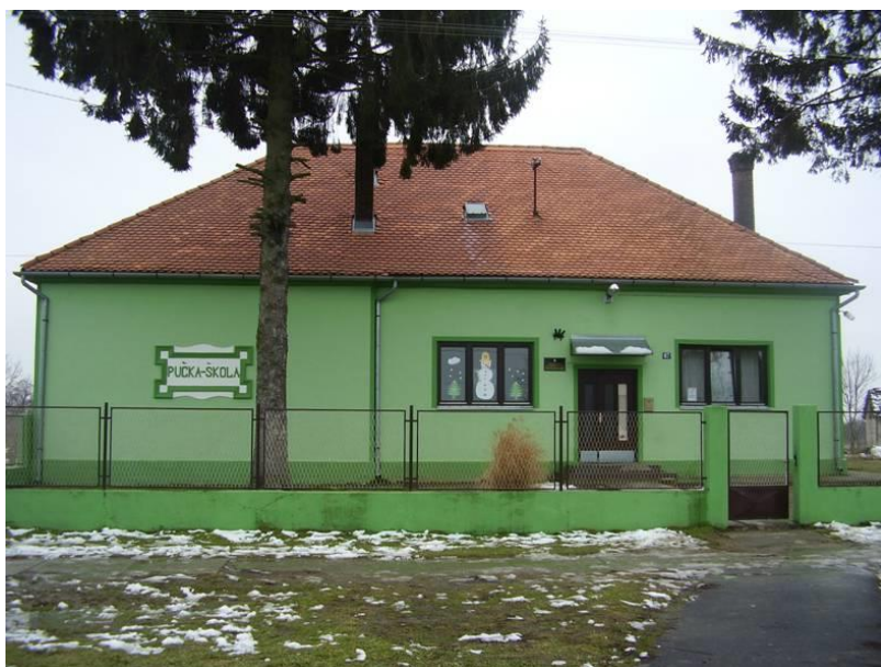
Slika 15: Stara školska zgrada u naselju Podravska Moslavina
